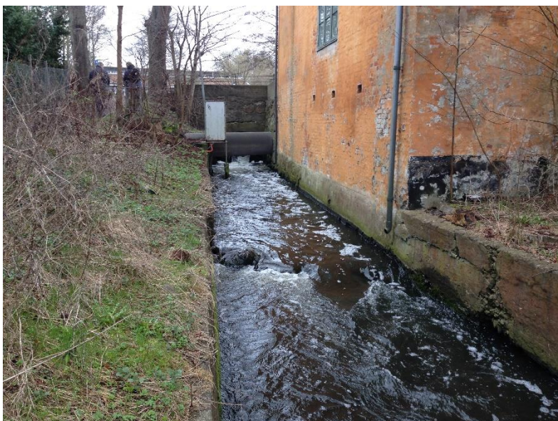
Nuværende underføring og faunaspærring af Håndværkersvinget nedenfor Mølledam, april 2016. Strækningen nedstrøms er med godt fald og gode fysiske forhold.
