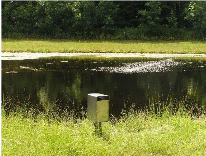
Iltning af sø med lavtrykskompressor og bobleslange
